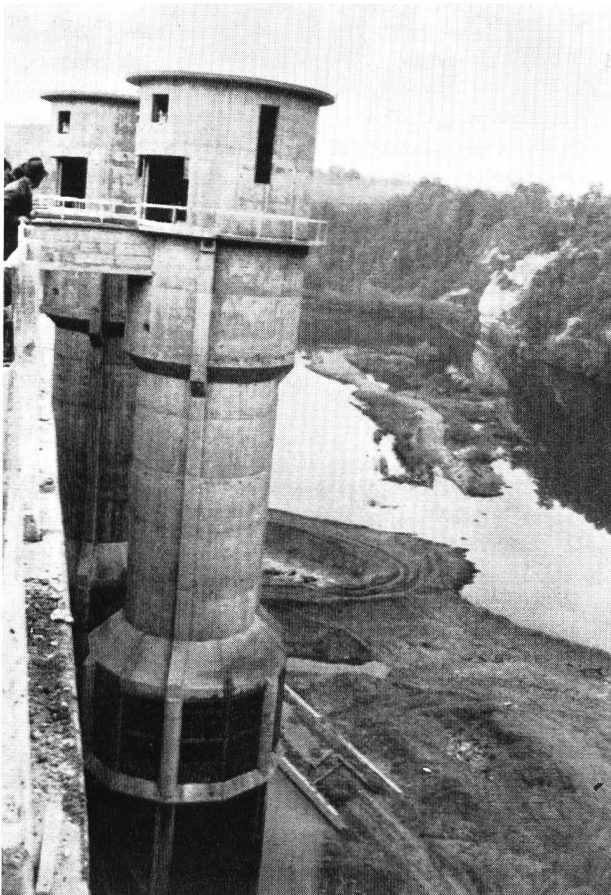
Bld 2 Türme für die Wasserentnahme für das Kraftwerk Schiffenen
