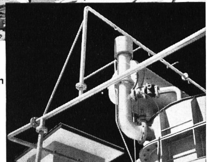
Vue d'ensemble des transformateurs avec les rampes de pulvérisation et détails de construction et de disposition des buses.
