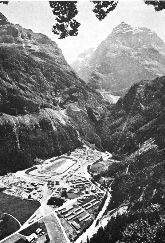
Bild 21 Blick auf den großen Werkplatz mit Ausgleichbecken Tiefehd und Drahtseilen der diesen Bauplatz mit verschiedenen hochgelegenen Baustellen verbindenden kühnen Seilbahnen
