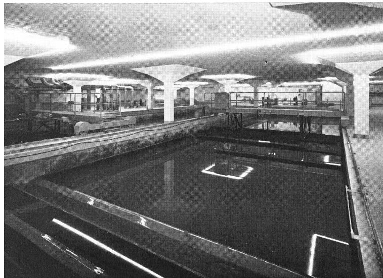
Bild 5 Unterirdisch angeordnete Vorklärbecken in der Gemeinschaftsanlage Küsnacht-Erlenbach
