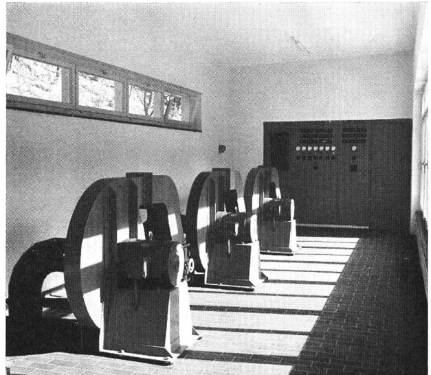
Bild 8 Ventilatorenanlage zur Erzeugung von Druckluft für die INKA-Belüftung in der Sihltalkläranlage
