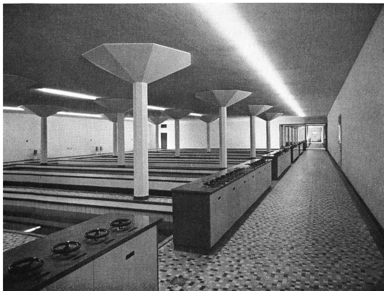
Bild 5 Halle der Schnellfiltergruppe 1 mit Sicht in die Halle der Schnellfiltergruppe 2; im Vordergrund Steuerpulte
