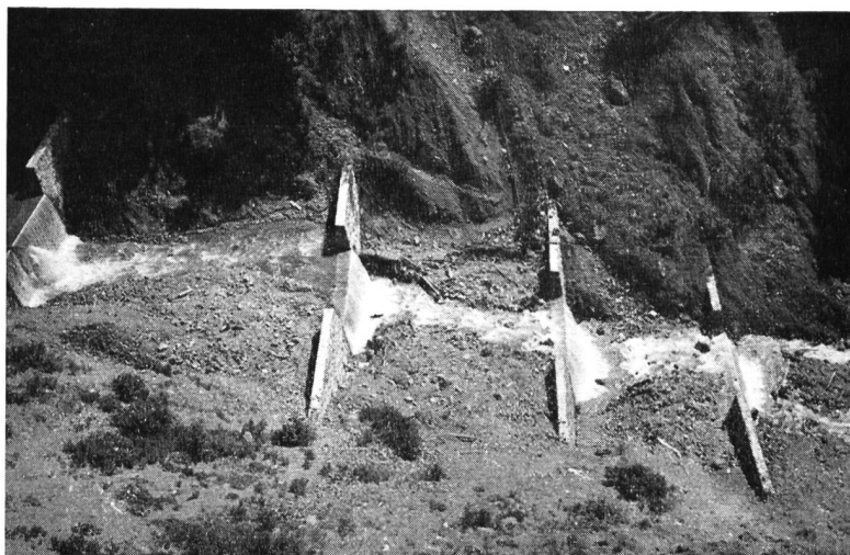
Bild 4 Sperren im Durnagelbach, Zustand im August 1954
