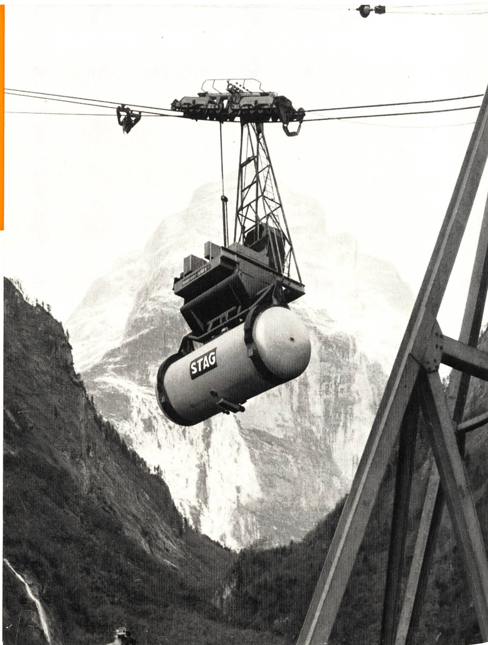
Schwerseilbahn der Kraftwerke Linth-Limmern AG STAG-Behälter von 16 t Fassungsvermögen für Zement
