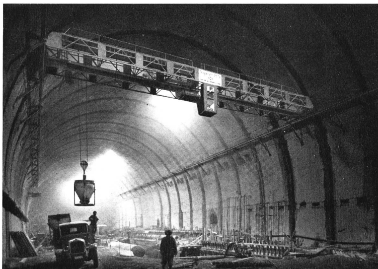
Maschinenhauskran für Kraftwerke Hinterrhein AG, Spannweite 22,3 m, Hubhöhe 13,2 m, Kranbahnlänge 142 m, Tragkraft 7,5 Tonnen
