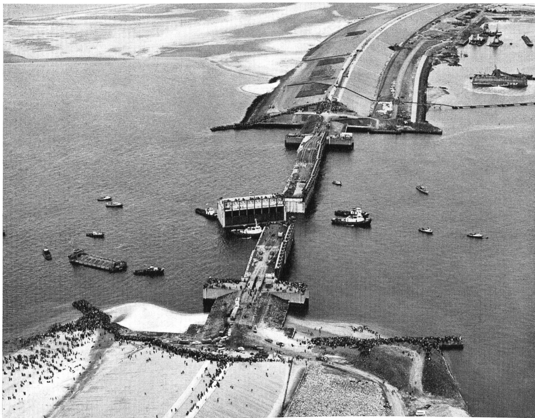
Bild 7 Schließung des ersten Dammes im Rahmen des Deltaplanes am 24. April 1961. Ein Seearm des Veersche Gat wurde mittels sieben Riesen-Beton-Senkkästen abgeriegelt, an beiden Seiten dieser Verschließung wurden 3 Mio m 3 Sand gespült; im November 1961 war dieser Damm, mit Asphaltbeton abgedeckt, vollständig fertig.
