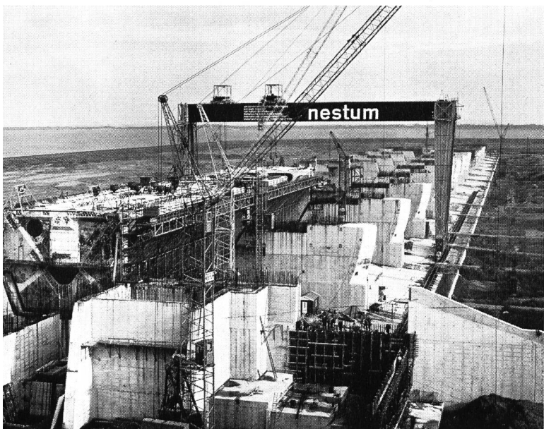
Bild 6 Im Haringvliet, einem Seearm von 4 km Breite, werden 17 Entwässerungsschleusen gebaut in einer Länge von mehr als 1 km. Diese Riesenbauten sollen 1968 fertig sein und im Zusammenhang mit den drei im Bau stehenden Rheinstauwerken den Wasserhaushalt Hollands verbessern. Die Entwässerungsschleusen verschließen ein Süßwasser-Speicherbecken und gestatten, das überschüssige Wasser der Flüsse Rhein und Maas zum Meer abfließen zu lassen, weil die übrigen Mündungen im Jahre 1978 von Dämmen verschlossen sein werden.
