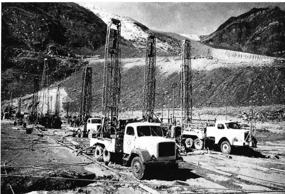
Bild 21 Bohrergeräte auf der Arbeitsplattform in Arbeit
