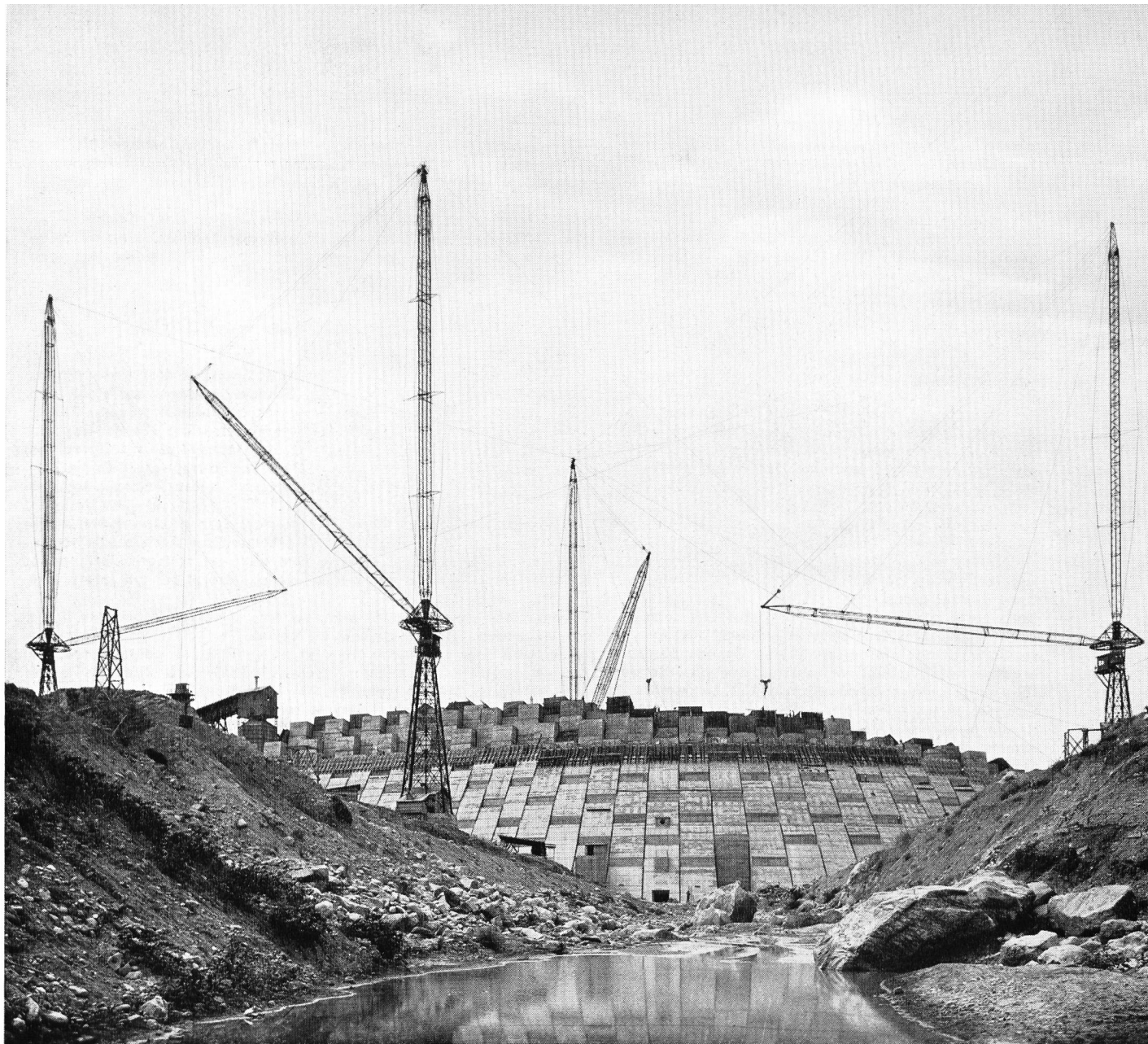
Talsperre Pozzillo auf der Insel Sizilien mit den für den italienischen Talsperrenbau so charakteristischen großen Derrick-Kranen (Photo G. Chiolini, Pavia)
