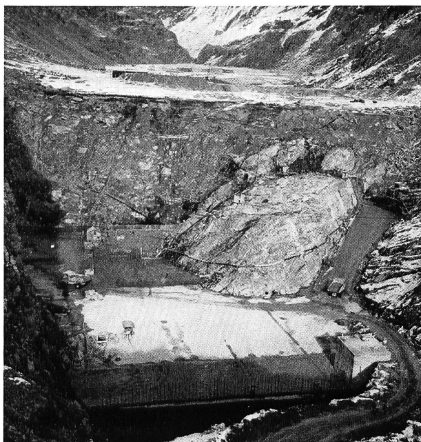
Fig. 10 Barrage de Alpe Gera; bétonnage du massif de fondation
