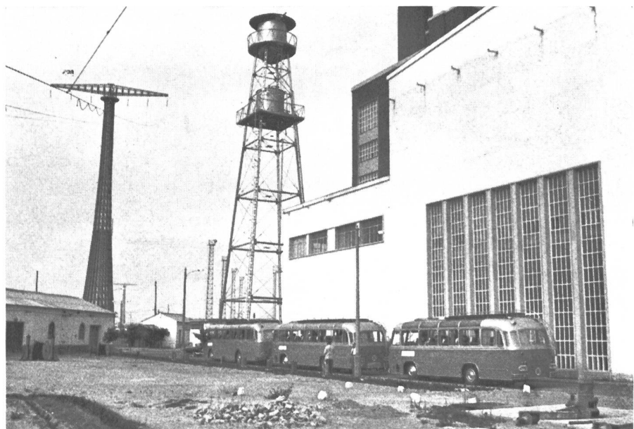
Bild 79 Thermische Zentrale der Stadt Cádiz in Süds Spanien, links südlicher Hauptmast für die 1640 m weit gespannte 138-kV-Leitung über die Meeresbucht von Cádiz. Im Vordergrund die drei Cars der Reisegruppe SO der WPC
