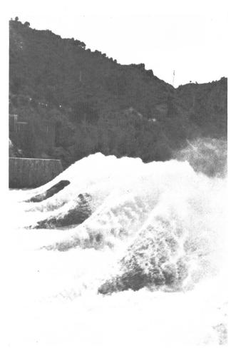
Bild 30 Demonstration eines Durchflusses von 200 m³/s über den Hochwasserüberlauf der Staumauer Bolarque
