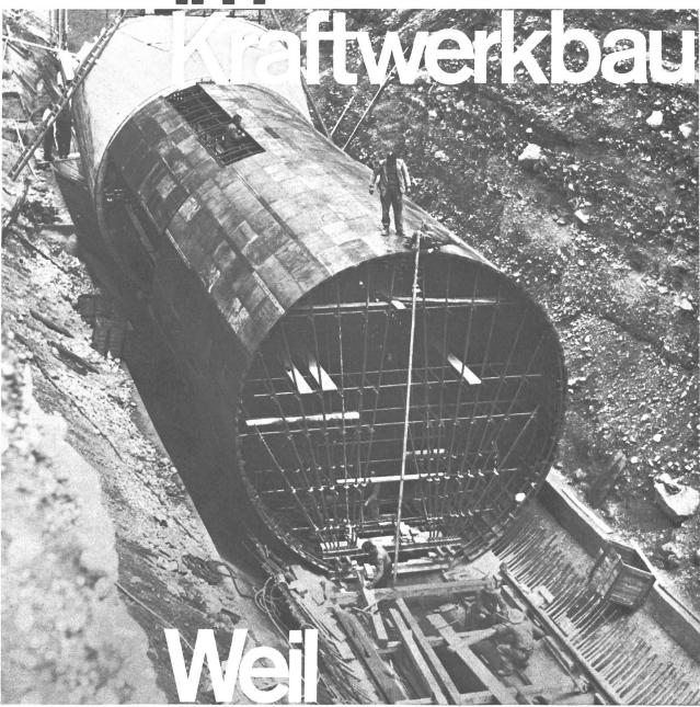
Bauobjekt Kraftwerk Reichenau. Druckrohr: Fahrbare Schalung aus ACROW-Normelementen, Innen-Ø 9,10 m,
