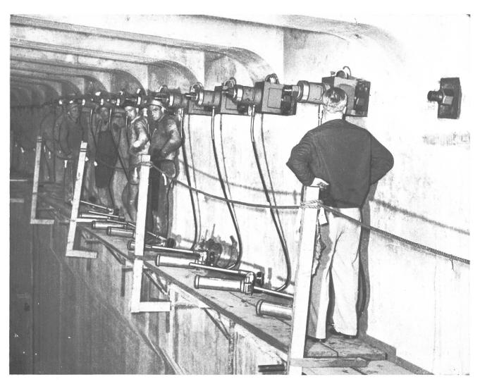
**Oben:** Eine Batterie von Einzelstab-Spannvorrichtungen mit zehn SIMPLEX-Remotrol RP6A-613, distanzbetätigt, 54 t, 76 mm Hub, 41 mm Zentrumloch- $\phi$ . Über 30 weitere Zentrumlochzylinder ab 27 bis 540 t, 50,8 bis 600 mm Hub und darüber und 27 bis 200 mm Zentrumloch- $\phi$ , mit entsprechender Handoder Motorpumpe, sind lieferbar.
