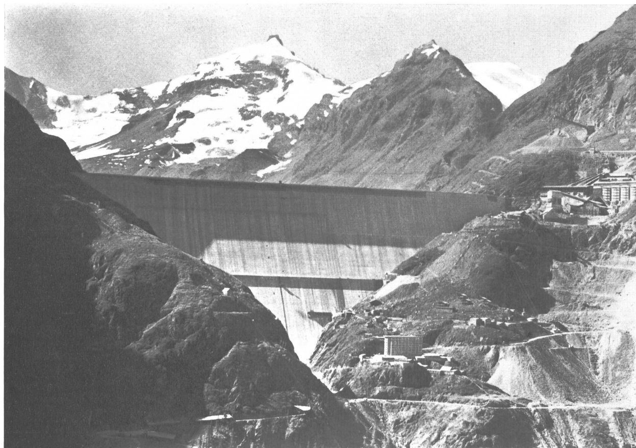
Eild 1 Die nach achtjähriger Betonierarbeit im September 1961 vollendete Gewichtsstaumauer Grande Dixence im Kanton Wallis
