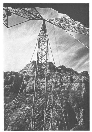
Bild 5 Die für eine italienische Bauunternehmung typische Derrick-Krananlage für die Betonierung einer großen Staumauer
