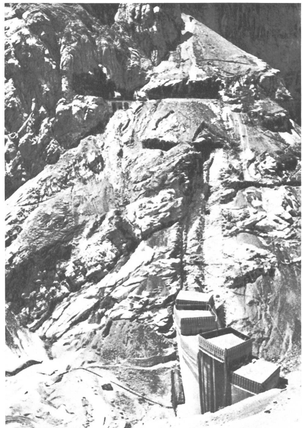
Bild 6 Widerlager-Aushub und Fundament der Bogenstaumauer Limmernboden; Zustand 15. Juni 1961 (vgl. Bild 6, S. 333 dieses Heftes)
