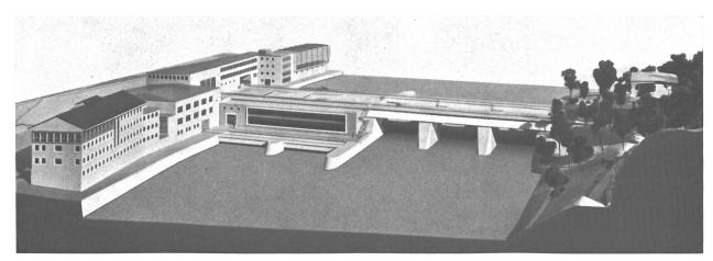
Bild 5 Modell für Stauwehr und Maschinenhaus. Am rechten Rheinufer (von links): Werkgebäude EW Sch, 10-kV-Schaltanlage, städtisches Pumpspeicherwerk, Verbindungsbau, 50-kV-Schaltanlage KWS; quer zum Rhein: das Maschinenhaus mit dem Deckel der Montagegrube (links) und den beiden Deckeln, unter denen sich die Turbinen-Generatorengruppen befinden, anschließend das Stauwehr mit drei Öffnungen
