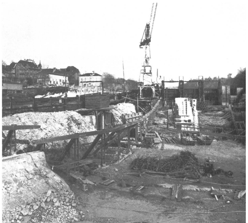
Bild 9 Baugrubenabschluß mit der Stützkonstruktion für die Spundwand; im Hintergrund das Hilfswehr. Aufnahme vom 21. Februar 1961
