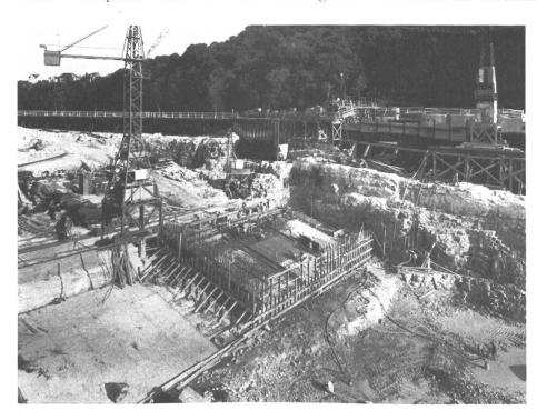
Bild 10 Maschinenhausbaugrube vom Unterwasser aus, am 1. September 1961; Beginn der Betonierarbeiten für die Einlaufsohlen der Turbinen
