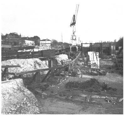
Bild 9 Baugrubenabschluß mit der Stützkonstruktion für die Spundwand; im Hintergrund das Hilfswehr. Aufnahme vom 21. Februar 1961
