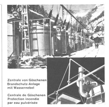
Gesamtansicht der Transforma-toren mit Rohrleitungssystem und Sprühnebeldüsen sowie Detailansicht der Konstruktion und der Anordung der Düsen.
