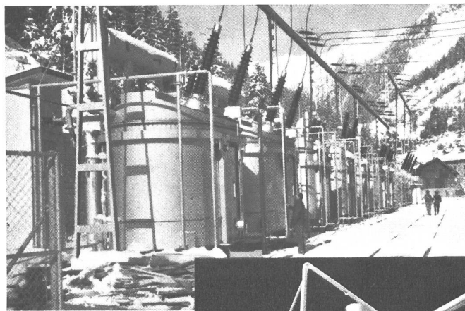
Zentrale von Göschenen Brandschutz-Anlage mit Wassernebel
