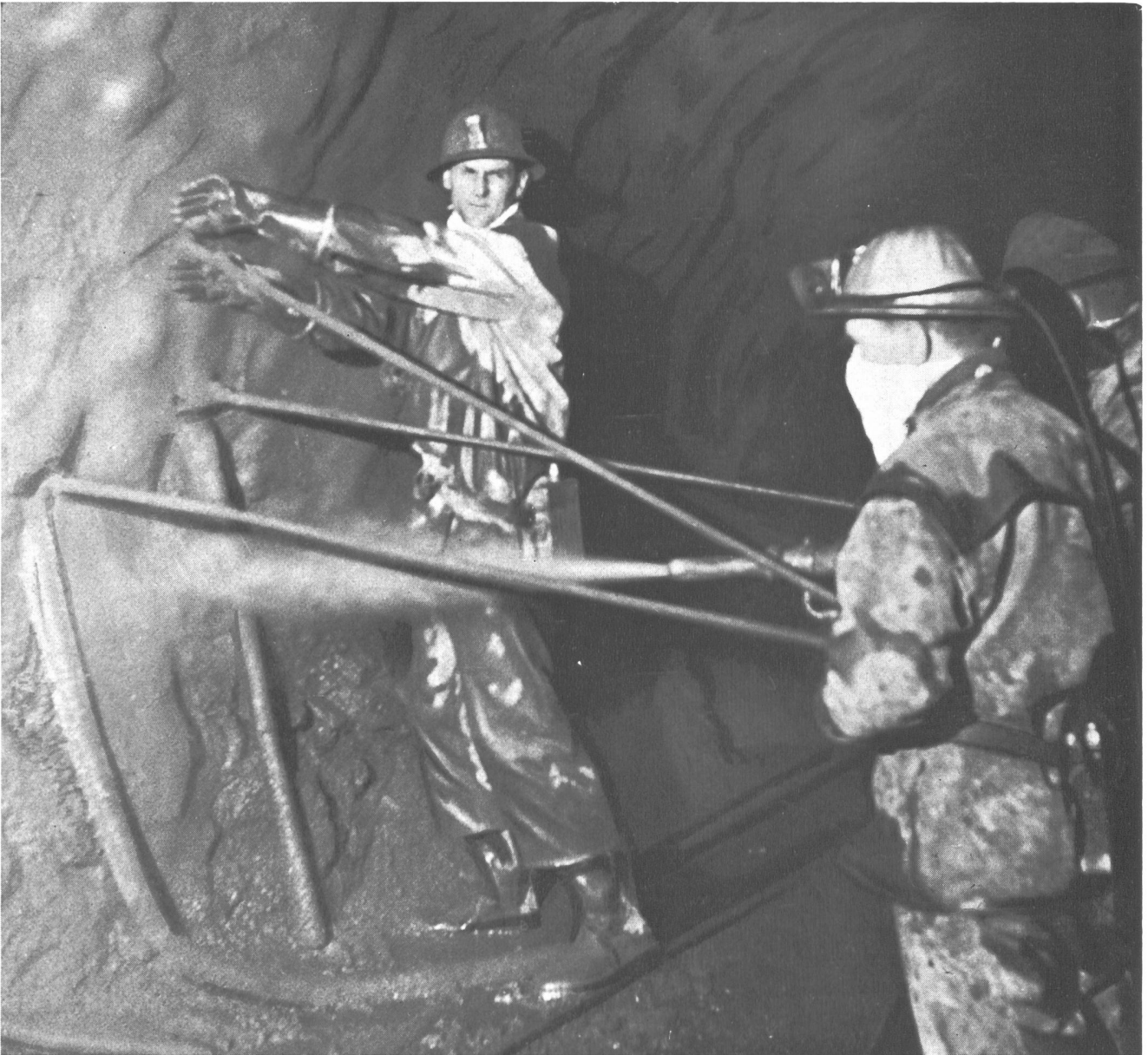
Unsere Spezialisten beim Abdichten eines Stollens
