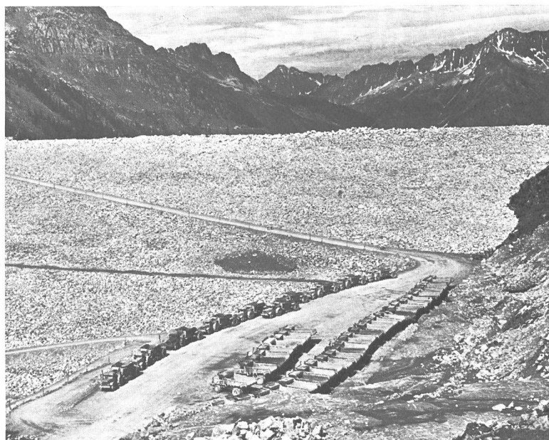
Fig. 10 GÖSCHENERALP Vue du pavé amont du barrage — Ansicht der Wasserseite — Sight of the upstream face of the dam (Photo: E. Brügger, 16. 7. 1960)
