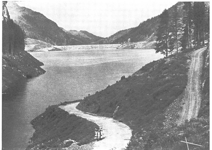
Fig. 5 CASTILETTO-MARMORERA Pavement amont — Damm-Wasserseite — Upstream face (Photo: E. Brügger)
