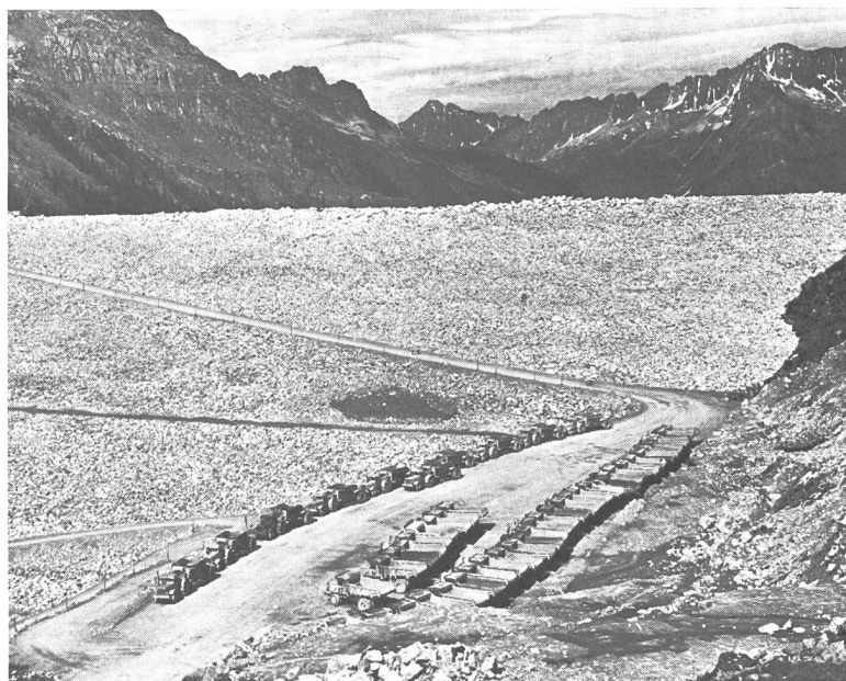
Fig. 10 GÖSCHENERALP Vue du pavé amont du barrage — Ansicht der Wasserseite — Sight of the upstream face of the dam (Photo: E. Brügger, 16. 7. 1960)
