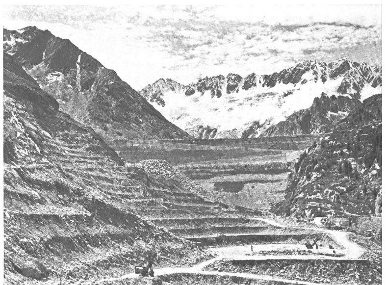
Fig. 11 GÖSCHENERALP Vue du pavé aval — Ansicht der Luftseite — Sight of the down- stream face (Photo: E. Brügger, 16. 7. 1960)
