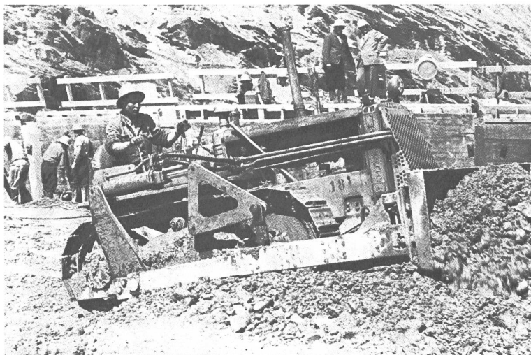
Fig. 2 Epandage du béton par bulldozer — Betonausbreitung mit der Planierdraupe Spreading of the concrete by bulldozer
