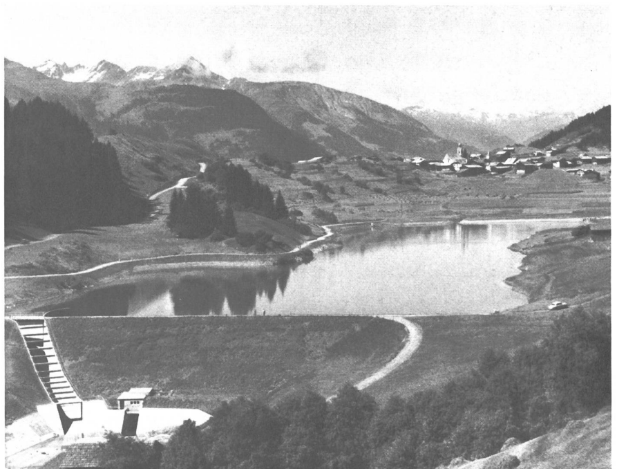
Staudamm Brigels, Abdichtung des Untergrundes durch Injektionsschirm mit OPALIT
