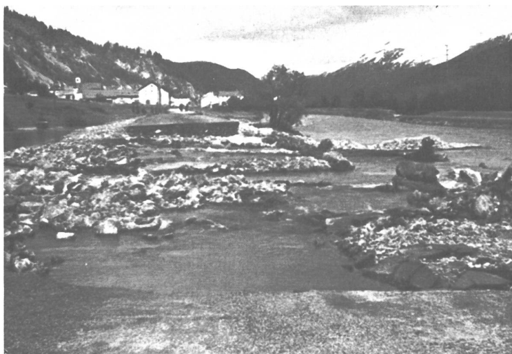
Bild 2 Inndamm- und Straßenbruch auf der Stecke Bever—La Punt; Blick talabwärts
