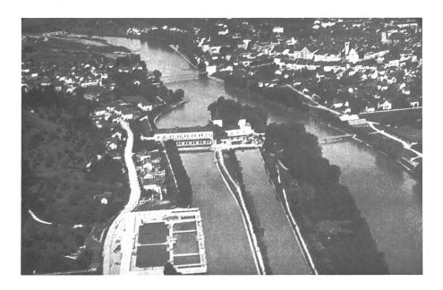
Bild 7 Die Kraftwerkanlagen mit den ungünstigen Fließverhältnissen vor dem Umbau
