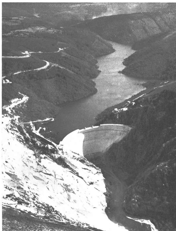
Bild 18 Stausee Eume am Río Eume in der Nordzone. Staumauerhöhe 103 m, Speichereinhalt 125 Mio m 3 , erstellt 1960
