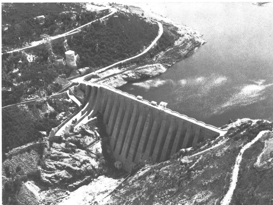
Bild 10 Stausee Chandreja am Río Navea in der Nordzone (im Plan Zone I, Nr. 14) Staumauerhöhe 85 m, Speicherinhalt 60,7 Mio m 3 , erstellt 1953
