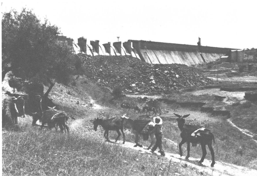
Bild 59 Esel und Maultiere, die nützlichsten und genügsamsten Nutztiere der Mittelmeerzone werden hier kolonnenweise sogar noch für den Sand- und Kiestransport bei einer modernen Großbaustelle eingesetzt (Staumauer Orellana)
