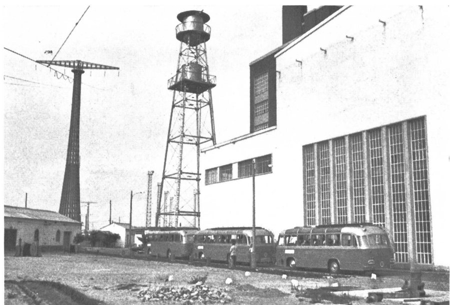
Bild 79 Thermische Zentrale der Stadt Cádiz in Südsanien, links südlicher Hauptmast für die 1640 m weit gespannte 138-kV-Leitung über die Meeresbucht von Cádiz. Im Vordergrund die drei Cars der Reisegruppe SO der WPC
