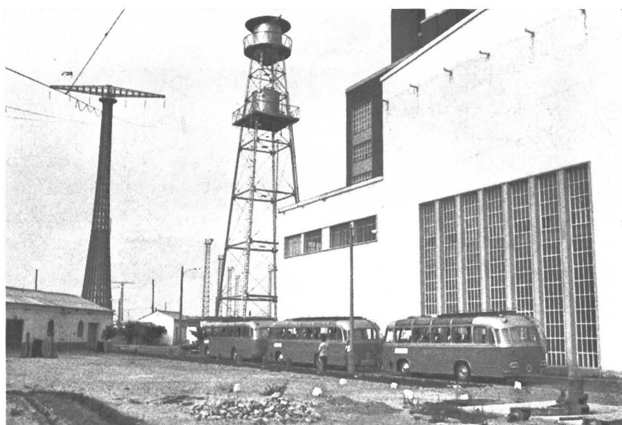
Bild 79 Thermische Zentrale der Stadt Cádiz in Südspanien, links südlicher Hauptmast für die 1640 m weit gespannte 138-kV-Leitung über die Meeresbucht von Cádiz.
