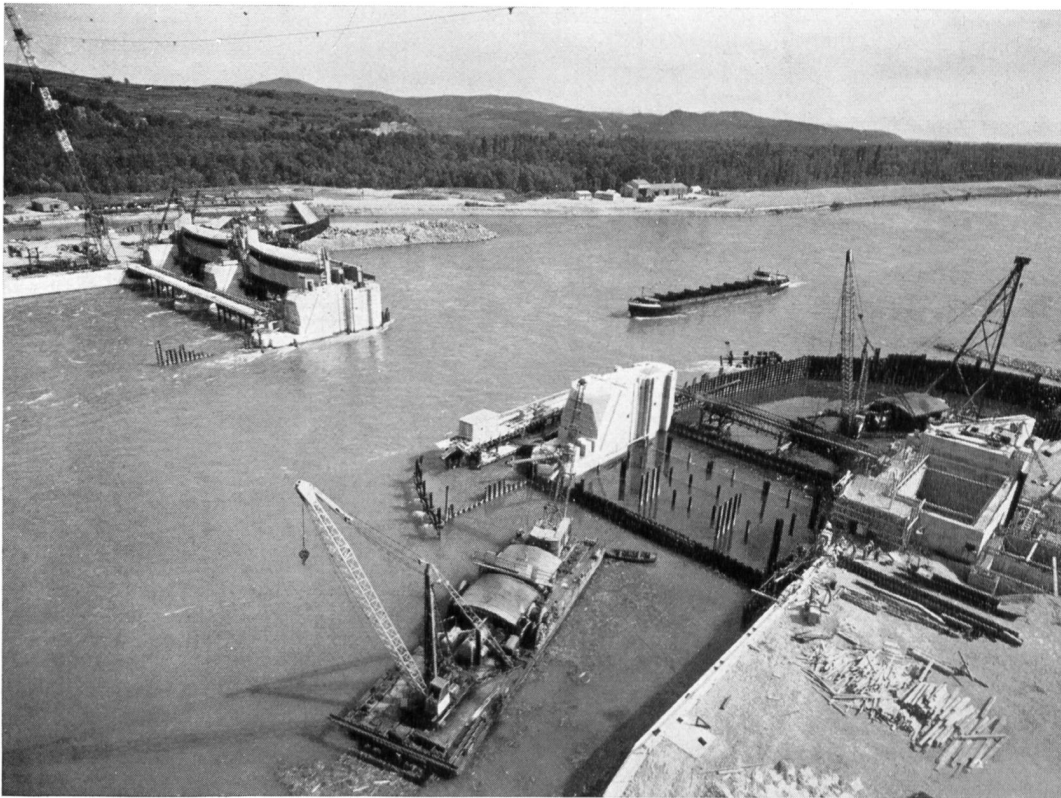
Bild 8 Bau des Stauwehres der Stufe Marckolsheim bei Burkheim unterhalb Breisach, 5. Stufe des Ausbaues Basel-Strasbourg für Wasserkraftnutzung und Schifffahrt. Aufnahme August 1960, gleiche Stelle wie bei Bild 1 (Photo H. Baranger, Paris)
