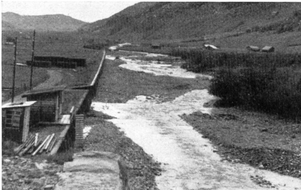
Bilder 4 und 5 Sihl bei Studen vor und nach der Verbauung; Blick vom Geschiebesammler flussabwärts, Blockwurf-Pflasterung der Sohle entsprechend dem geschiebelosen Abfluß unterhalb des Sammlers. (Photo Schmid O. B. I.)
