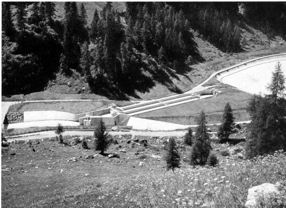
Bild 15 Wasserfassung, Entsandungsanlage und Ausgleichbecken Motec der Kraftwerkgruppe Gougtra im Val d'Anniviers
