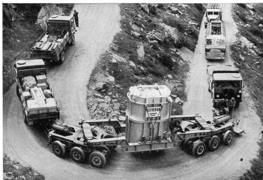
Bild 12 Transport eines 60-Tonnen-Transformators auf der engen und kurvenreichen Gebirgsstraße nach Fionnay. Drei Welti-Furrer-Straßenschlepper ziehen und stoßen diese Schwerlast auf der 16% steilen Straße nach dem Kraftwerk Mauvoisin.
