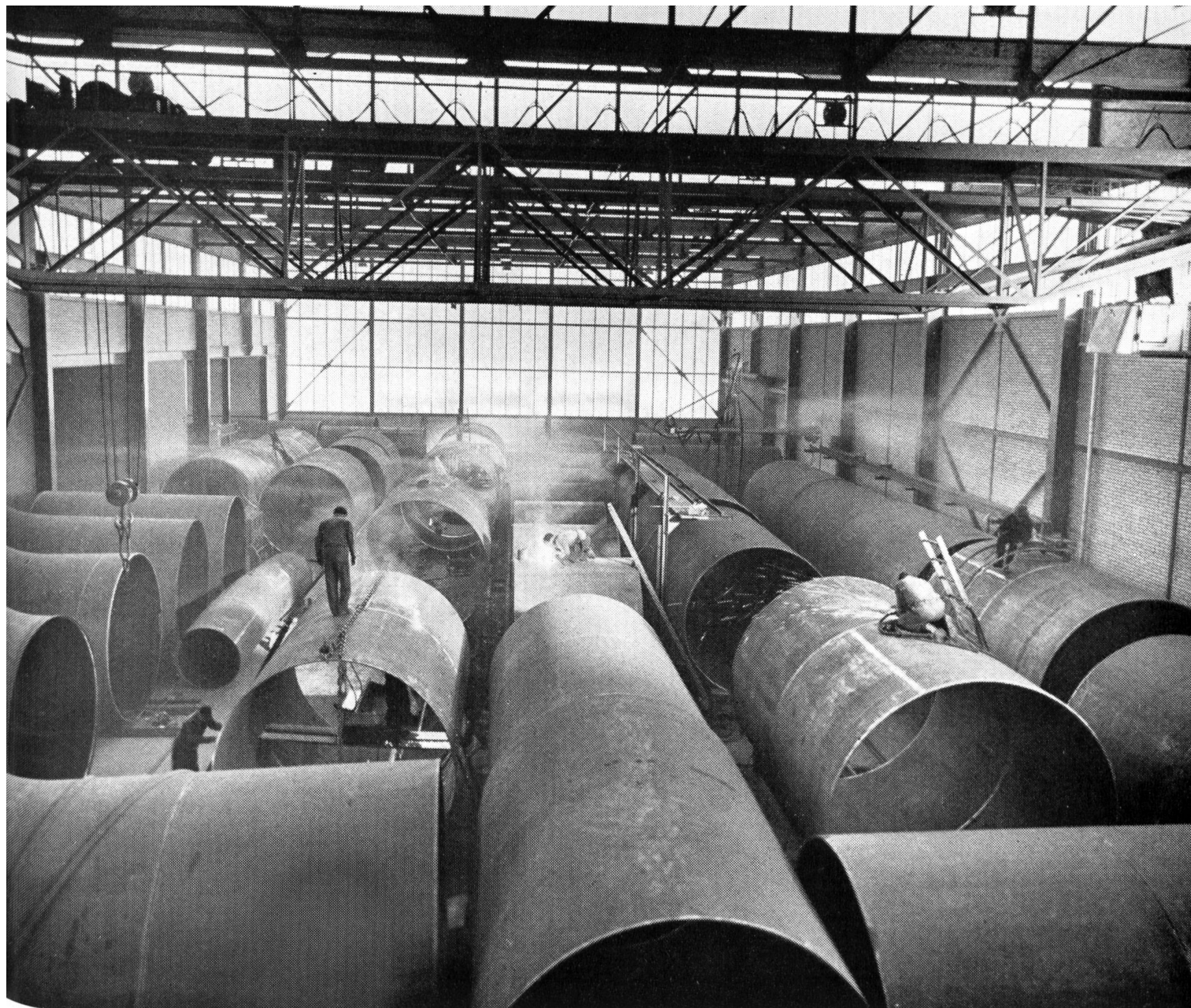
Panzerrohre in Fabrikation
