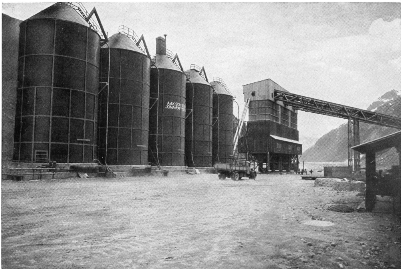
Staudamm Göschenenalp, Tonpulver-Siloanlage, 5 Silo à 1000 m 3 Inhalt
