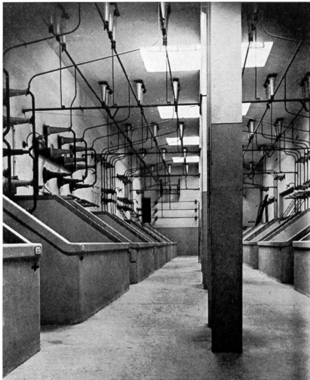
Bild 1 Kraftwerk Gösgen, 50/70-kV-Sammelschienenraum; Projekt Motor-Columbus AG
