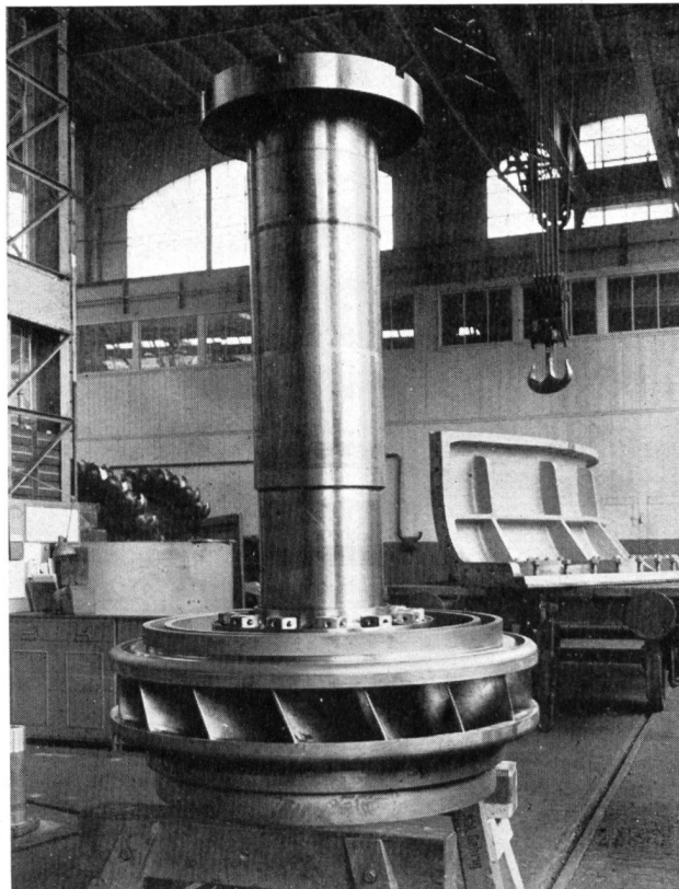
Bild 8 Extremer Francis-Langsamäufer für hohes Gefälle; Laufrad für eine der Turbinen des Kraftwerkes Fionnay/Mauvoisin, 62 800 PS, H etwa 455 m (1956) Photo Escher-Wyß
