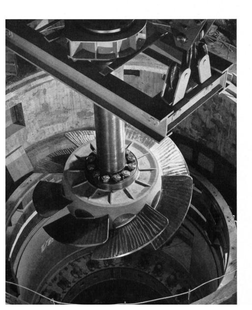
Bild 11 Montage eines 8schaufligen Kaplanrades im Kaftwerk Lavey; 33 650 PS, H 42 m (1948)
