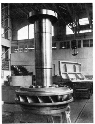
Bild 8 Extremer Francis-Langsamläufer für hohes Gefälle; Laufrad für eine der Turbinen des Kraftwerkes Fionnay/Mauvoisin, 62 800 PS, H etwa 455 m (1956)
