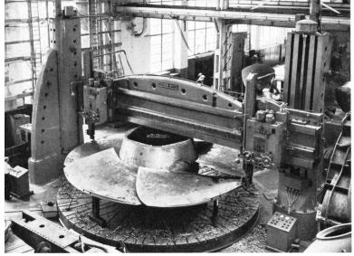
Bild 10 Maschinelle Bearbeitung eines 5schaufligen Kaplanlaufrades; Überdrehen der kugeligen Außenbegrenzung. Photo Escher-Wyß
