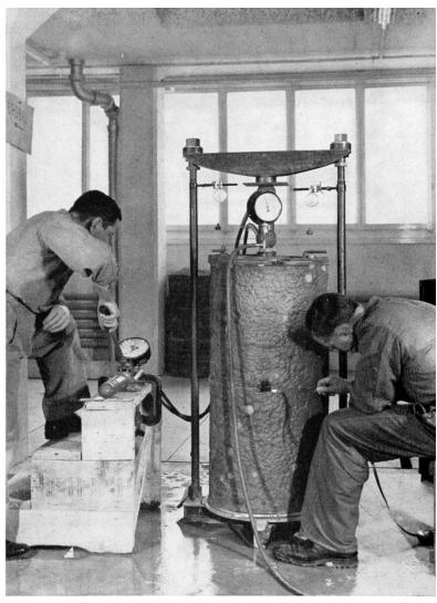
Bild 20 Probe nach der Durchführung eines Versuches im Vakuum-Triaxialgerät. F = 2000 cm<sup>2</sup>
