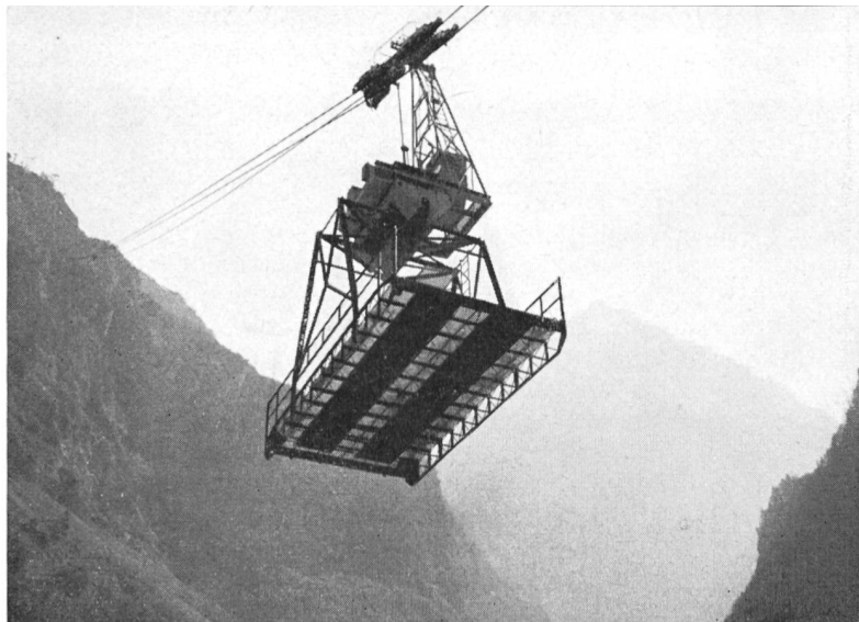
Bild 4 Mit der außerordentlich kühnen Schwerseilbahn für 18-t-Lasten wird die große Höhendifferenz in kürzester Zeit überwunden
