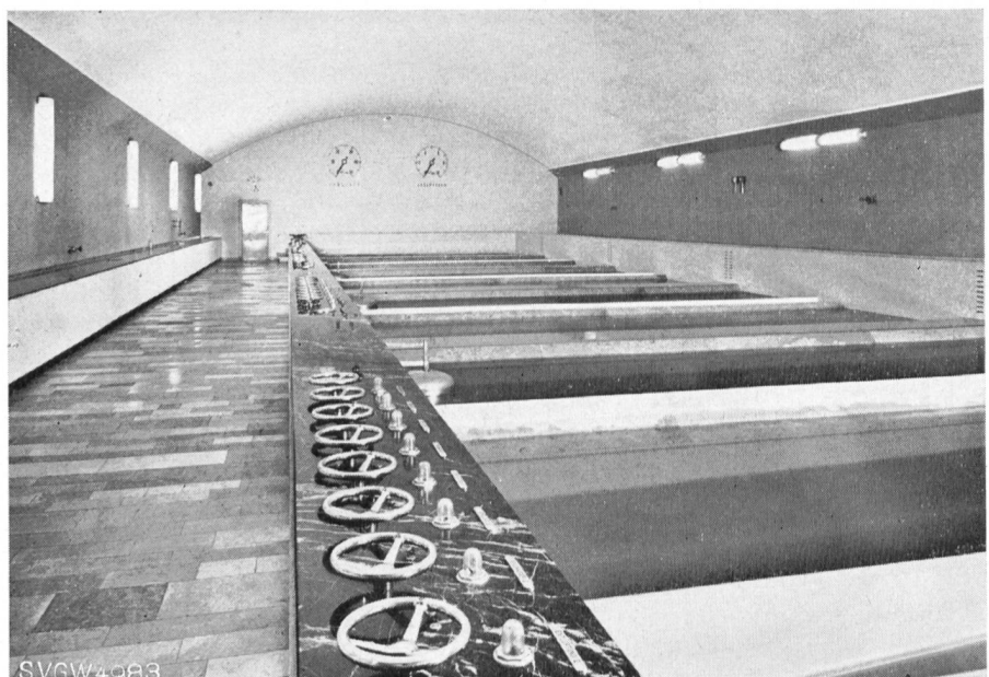
Bild 5 Schnellfilteranlage in der Anlage Könizberg der Wasserversorgung Bern
