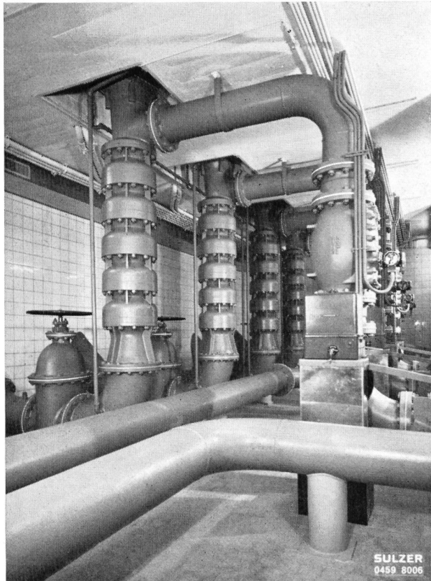
Bild 4 Rohrkeller; vier Bohrlochpumpen und Absperrorgane im Stufenpumpwerk Waid der Wasserversorgung St. Gallen
