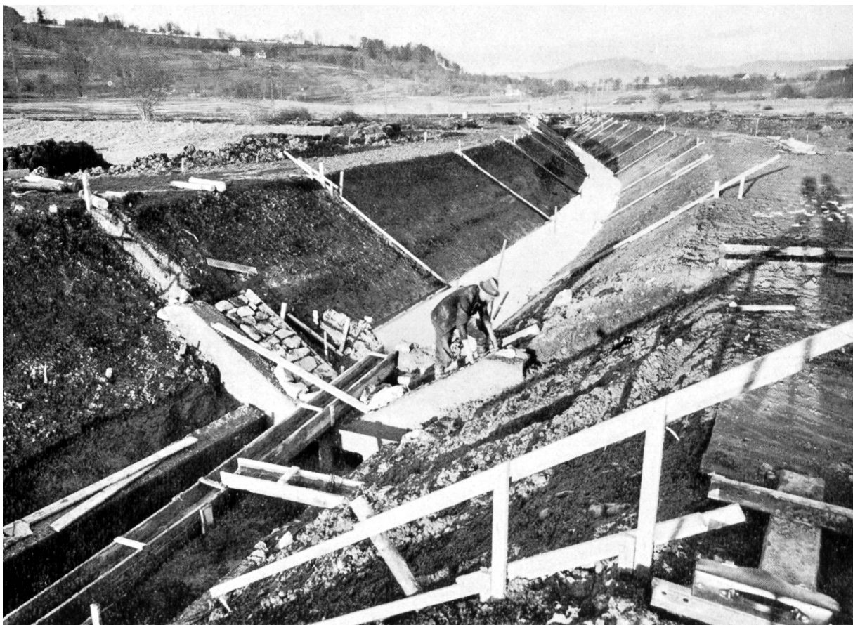
Bild 1 Vorflut-Kanal im Bau
