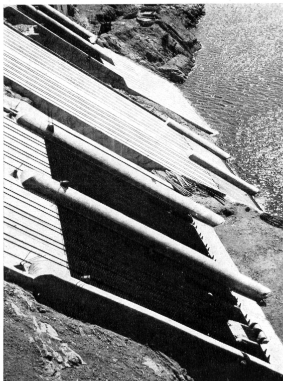
Kraftwerk Kariba (Rhodesien). Rechenreinigungsmaschine mit einer Hublänge für den Hakenwagen von 135 m.
