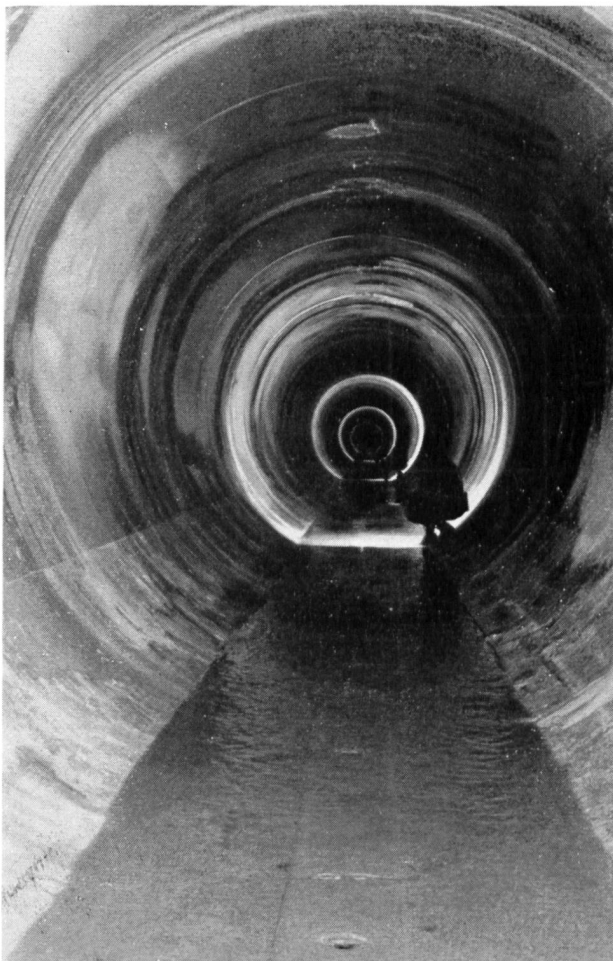
Bild 13 Verkleideter Druckstollen, lichter Durchmesser 3,25 m
