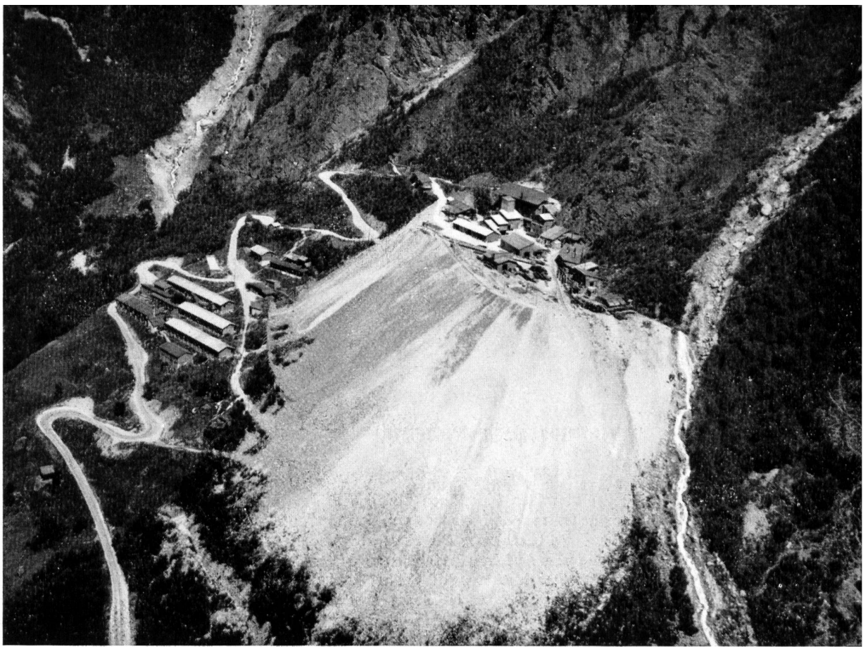
Bild 2 Großbaustelle im Gebirge: Stollenfenster für den Bau eines 9 km langen Stollens
