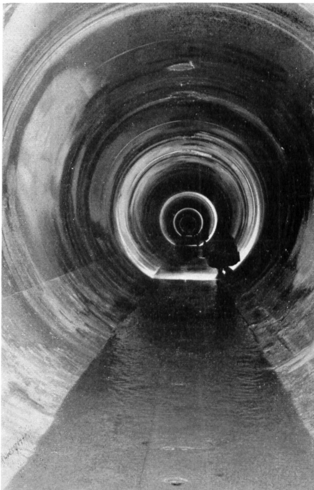
Bild 13 Verkleideter Druckstollen, lichter Durchmesser 3,25 m
