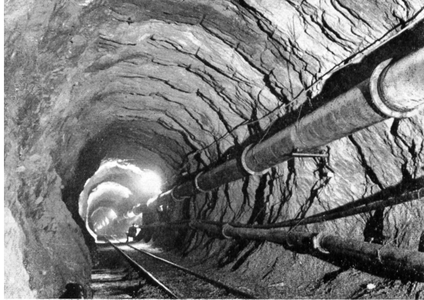
Bild 3 Druckstollen im Ausbruch, lichter Durchmesser 3,75 m
