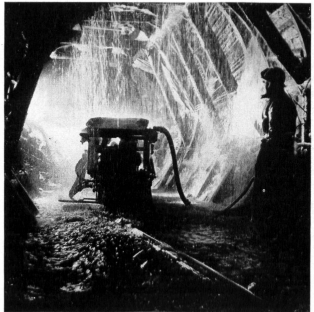
Bild 4 Stollenbagger im Vortrieb bei Wasserandrang
