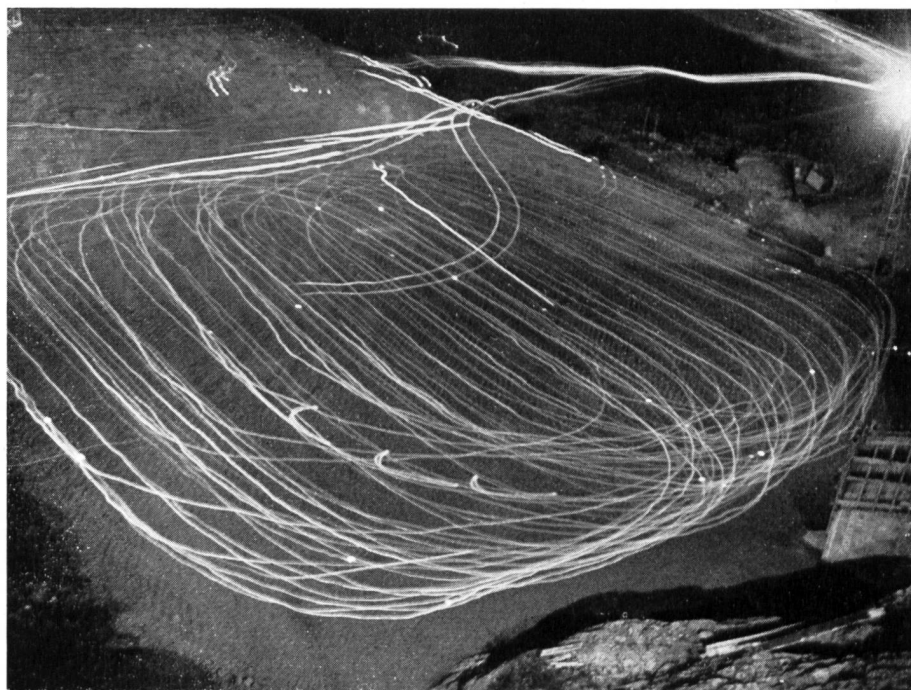
Bild 5 Staudamm Marmorera: Verdichten des Kernmaterials mit Schaffußwalzen, Nachaufnahme (Bauperiode 1950/55)
