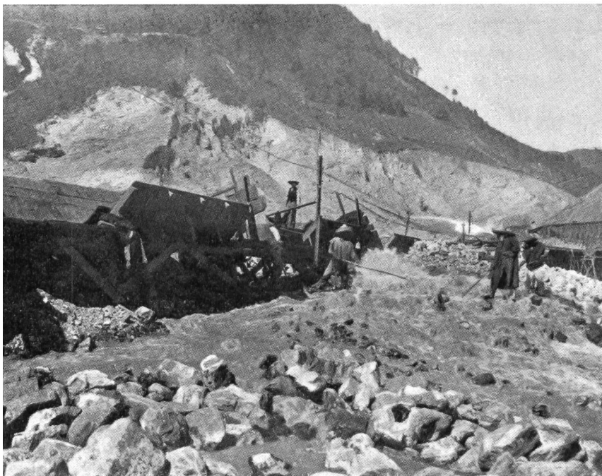
Bild 2 Necaxa-Damm in Mexiko: Einschwemmen des Damm-Materials (Bauperiode 1907/12)
