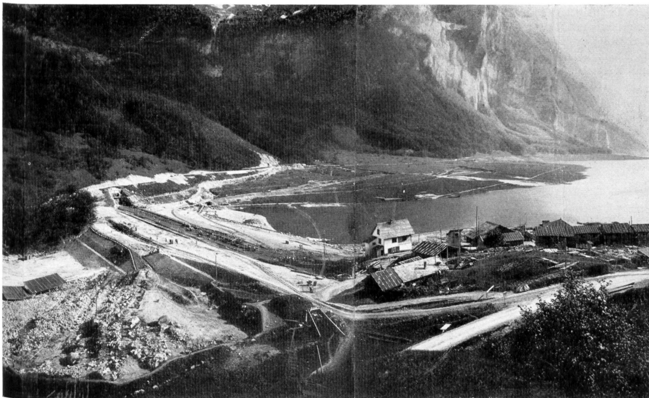
Bild 1 Staudamm Klöntalersee für das Elektrizitätswerk am Löntsch (Bauzustand April 1909)
