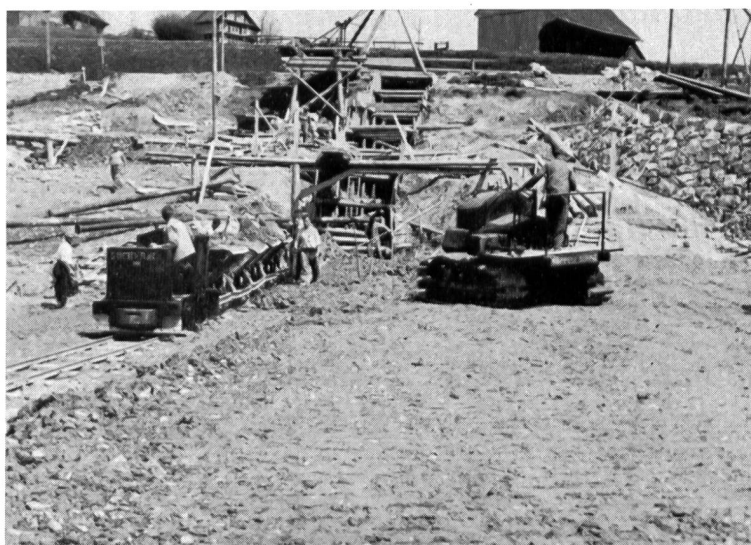
Bild 3 Hühnermatt-Damm: Einwalzen des Lehmkerns (Moräne) mit Raupentraktor 6 t; Einbau Filter mit Rollbahn in Schichten von 30 cm (Bauperiode 1934/36)
