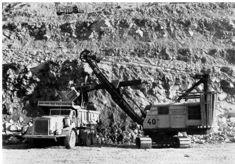
Bild 6 Staudamm Göscheneralp: Beladen eines Großfahrzeuges von 40 t Tragkraft durch einen Bagger mit 3 m 3 Löffelinhalt. Zu beachten ist das äußerst schwere Baggergüt (Bauperiode 1955/61)
