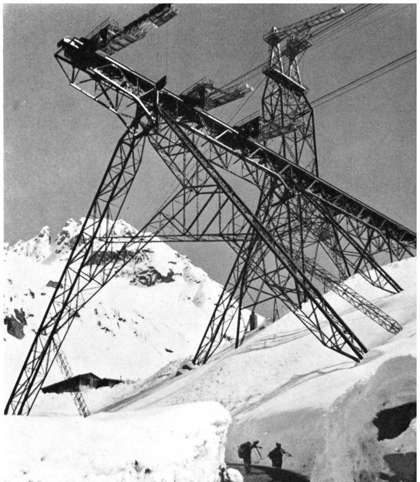
Bild 7 Staumauer Albigna: 3 parallel fahrbare Krane mit Gegenwagen auf großer Brücke; Gewicht der Eisenkonstruktion 290 t. Fester Kran auf etwa 75 m hohem Turm für die Betonierung der obersten Mauerpartie; Gewicht des Turmes 77 t
