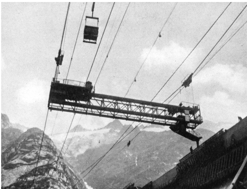
Bild 5 Staumauer Rätherichsboden: fester Kabelkran bedient Betonierbühne in der letzten Betonierphase der Staumauerkrone
