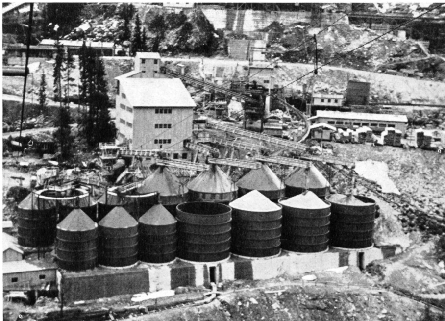
Bild 2 Siloanlage Zervreila; eiserne Silos auf Betonfundamenten mit Entnahmekanälen
