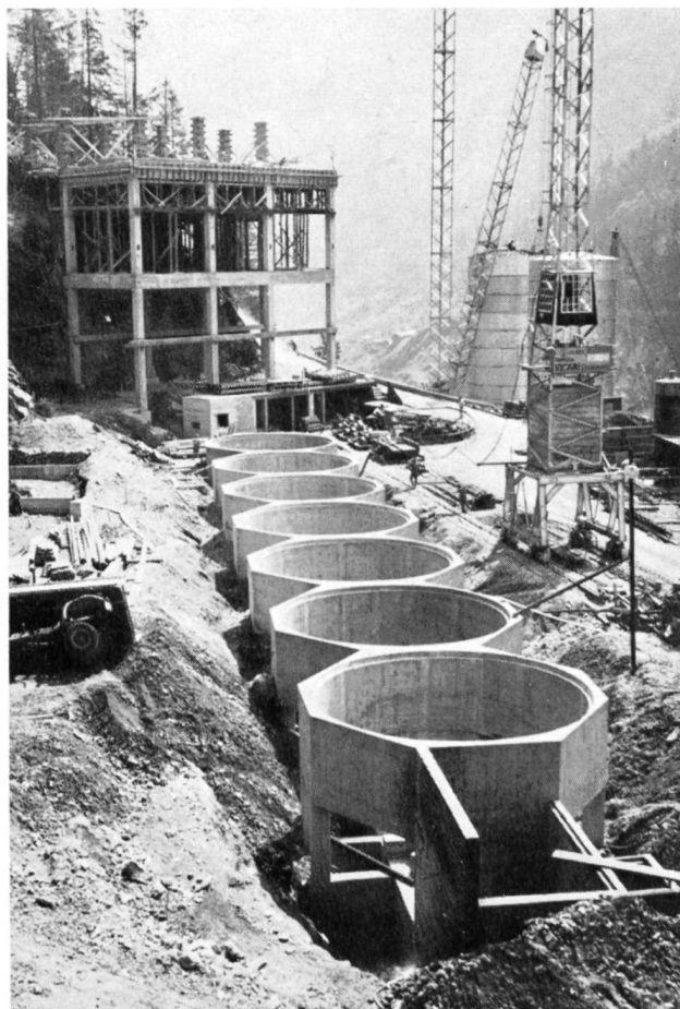
Bild 1 Fundamente der Sandsilos Luzzzone: armierte Eisenbetonringe über quadratischem Entnahmestollen
