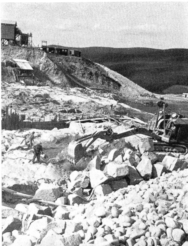
Bild 24 Großer Steingreifer an der Arbeit
