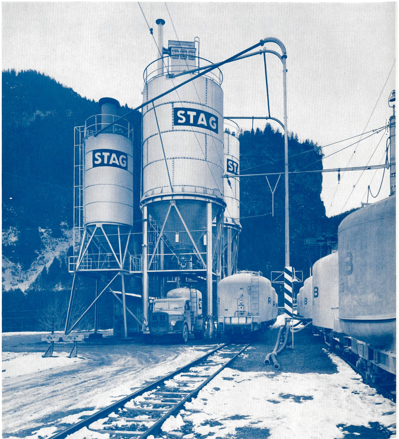
Umschlagsanlage Thuis der STAG : 2 Umschlagsilos à ca. 200 t für Normalzement 1 Umschlagsilo von ca. 65 t für Spezialzement
