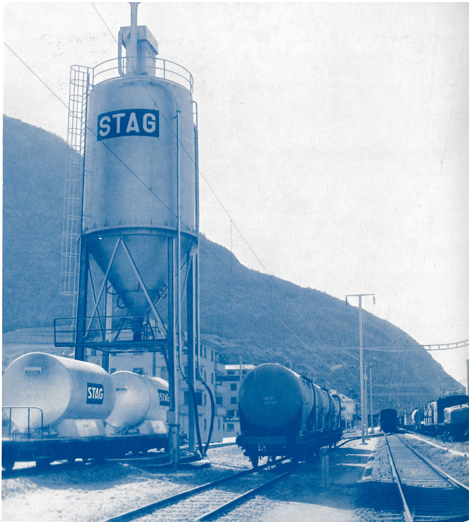
Umschlagsanlage der STAG in Visp (Wallis): Silo von etwa 200 t Fassungsvermögen. Umschlag von der SBB- auf die Visp-Zermatt-Bahn
