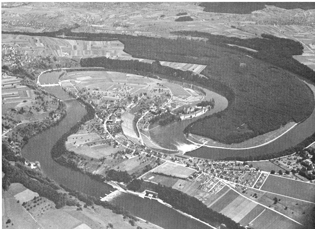
Bild 13 Grenzkraftwerk Rheinau mit Rheinschleife (Inbetriebnahme 1956). Rechts Hauptstauwehr mit Überlauf zur Dotierung der durch die Kraftnutzung abgeschnittenen Rheinschleife (der Auslauf des Unterwassertollens des Kraftwerkes ist im Vordergrund sichtbar). Die beiden Hilfswehre (links) sorgen für die gewünschte Wasserhaltung im abgeschnittenen Flußarm. (Fliegeraufnahme Swissair AG, Zürich)
