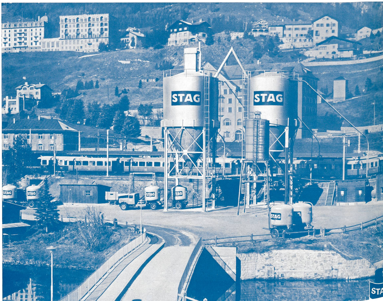
Umschlagsanlage der STAG in St. Moritz: 2 Silos à ca. 500 t Fassungsvermögen, 1 Silo à ca. 60 t Fassungsvermögen und Straßenfahrzeuge von 22 t Gesamttonnage und ca. 14 t Nutzlast
