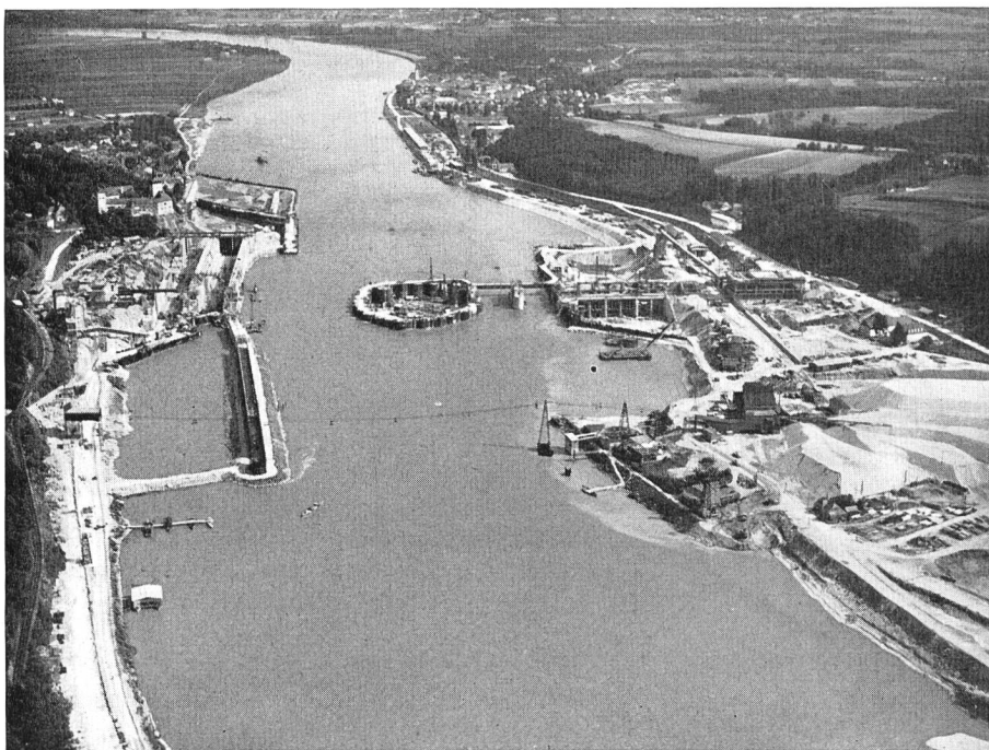
Bild 13 Baustellenübersicht, Bauzustand II (Aufnahme vom 3. August 1956)
