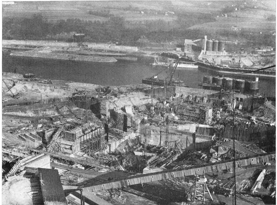
Bild 11 Bau des Kraftwerkes Süd, Bauzustand I (Aufnahme vom 29. Nov. 1955)
