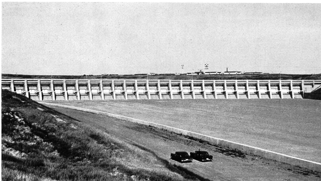
Bild 3 Garrison-Kraftwerk: Anlage für die Hochwasserentlastung
