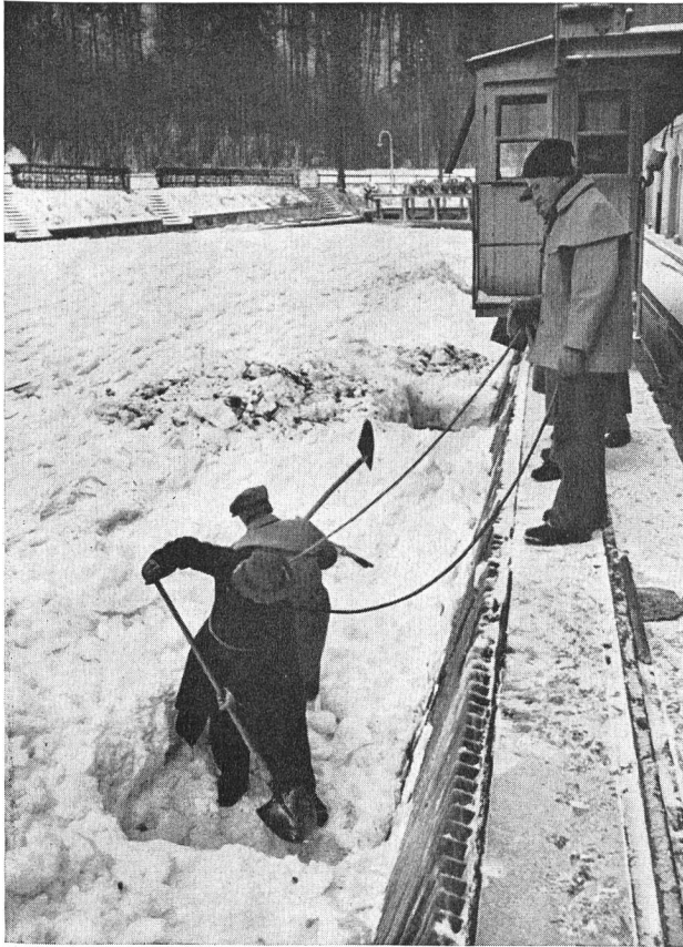
Bild 6 Rechen-Enteisung beim Kraftwerk Ruppoldingen (Photo ATEL)
