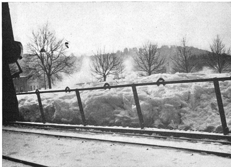
Bild 4 Eiswall vor dem Rechen des linksufrigen Werkes der Kraftwerke Wynau (Photo K. Achermann)
